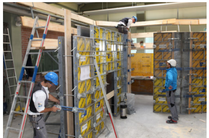
Im September hatten die Beton- und Stahlbetonbauer Timo Schön (li.) und Medin Murati ein intensives Techniktraining in Bayern.
