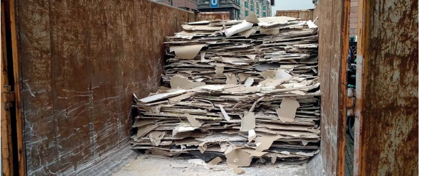
Verordnungskonforme Getrenntsammlung von Gipskarton (Foto: Behling/ZDB)
