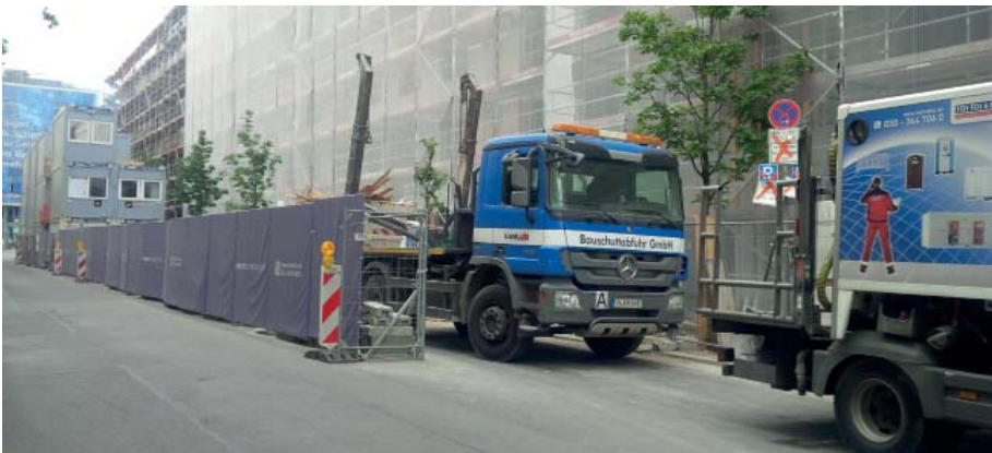
Ohne LKW ist das Bauen von Wohnungen in der Innenstadt nicht möglich.
