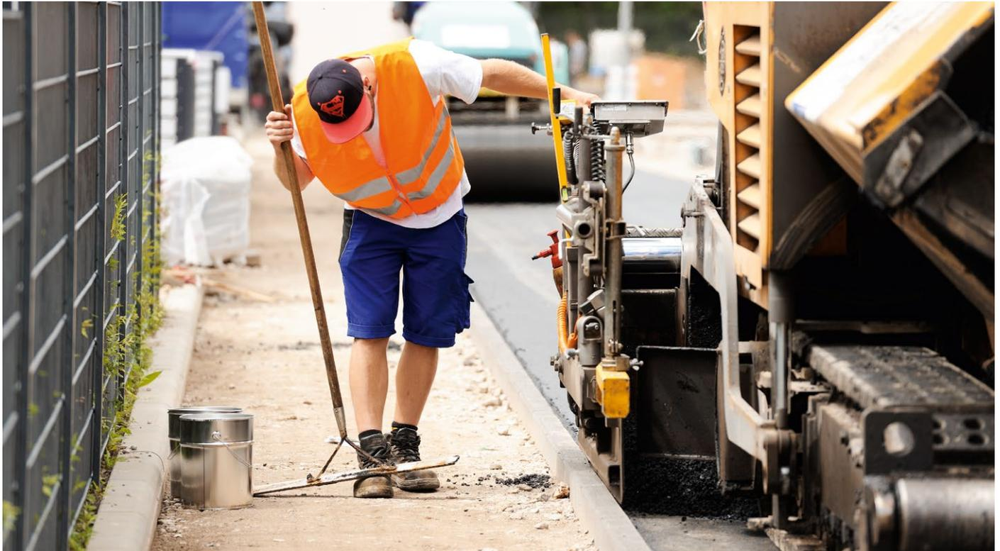
**Mit Änderung der Technischen Regeln für Gefahrstoffe (TRGS), vom 30.03.2020 führt das Bundesministerium für Arbeit und Soziales (BMAS) neue Arbeitsplatzgrenzwerte für Heißbitumen ein. Gemessen nach dem Bitumenkondensat-Standard, darf ein Wert von 1,5 mg/m<sup>3</sup> nicht überschritten werden. Allerdings findet diese Neuregelung, für die Bereiche Guss- und Walzasphalt, sowie Bitumen- und Polymerbitumenbahnen, erst nach einer Übergangsfrist bis zum 31. Dezember 2024 Anwendung.**
