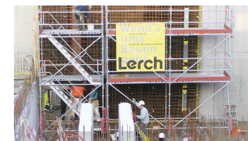
Schnell und sicher nach oben – Bewehrungsgerüst aus dem Layher Allround-System mit integrierter Podesttreppe. Bei dieser Lösung lässt sich als weiterer Vorteil zudem die für die Standfestigkeit notwendige Basisverbreiterung reduzieren.
