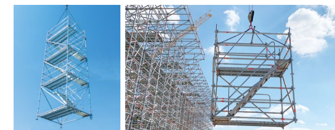
Beim einem Klinikneubau sorgte der Allround Modultreppenturm für einen sicheren Höhenzugang zu den Schalungsarbeiten. Die einzelnen Module wurden schussweise am Boden vormontiert und dank hoher Passgenauigkeit schnell per Kran zusammengesetzt. Auch der Kranversatz eines fertig montierten Allround Modultreppenturm ist problemlos möglich.
